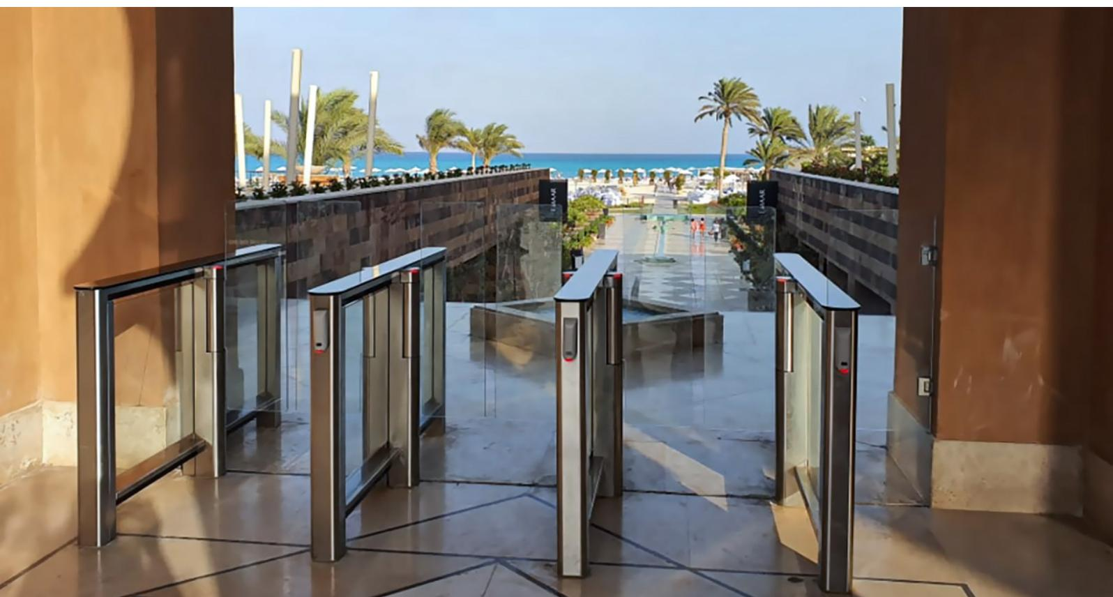
Тумбовые турникеты TTD-08A отличают уличное исполнение, повышенная износостойкость и функция автоматической антипаники для эвакуации людей в экстренной ситуации.
