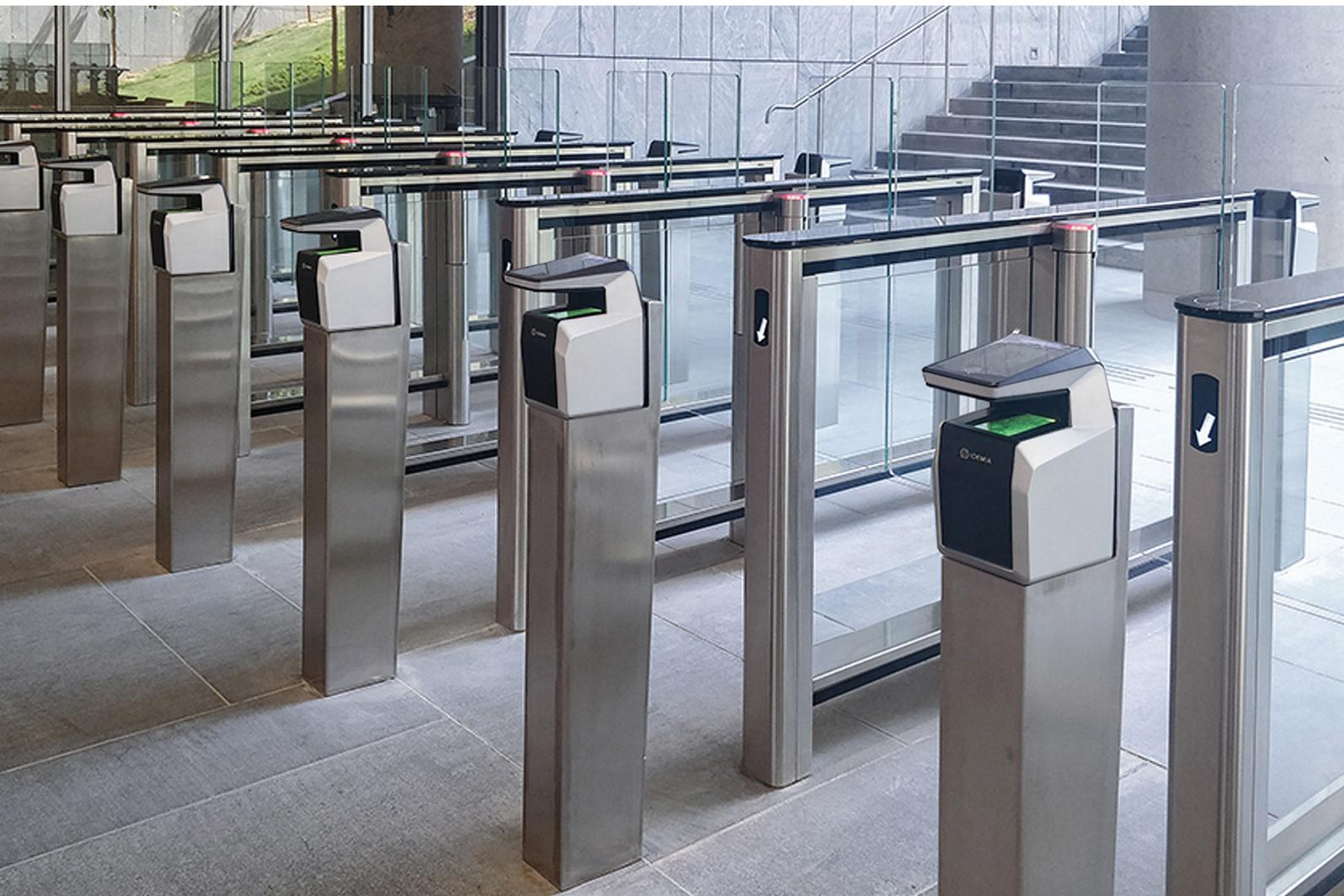
Доступ осуществляется по отпечаткам пальцев. Для реализации данного способа идентификации скоростные проходы ST-01 дополнены стойками с бесконтактными 3D сканерами.
