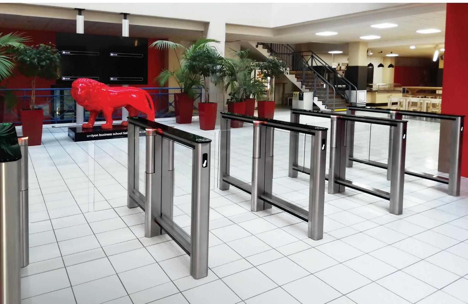
Скоростные проходы PERCo ST-01 — турникеты с распашными створками, обеспечивающие комфортный бесконтактный проход. В кампусах школы установлены скоростные проходы со стандартными створками и створками увеличенной ширины для организации доступа людей с ограниченными возможностями.
